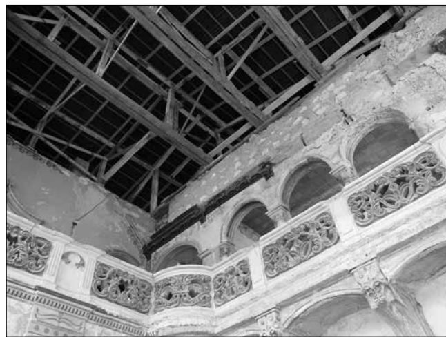
Pucér gerendák tartják a tetőszerkezetet...
